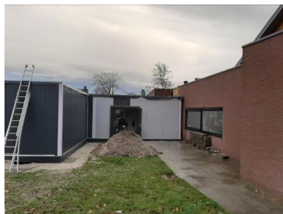
De aanbouw vordert gestaag
